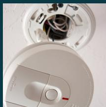
Al reemplazar detectores de humo interconectados, se recomienda reemplazar todas las unidades en el sistema al mismo tiempo. Si necesita reemplazar un solo detector averiado, asegúrese de que el nuevo detector sea compatible con las unidades existentes.
