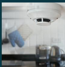
Si su detector de humo con frecuencia se activa cuando está cocinando, NO quite la BATERÍA NI EL DETECTOR. Considere mover el detector a otra ubicación o reemplazándolo con una unidad fotoeléctrica.
