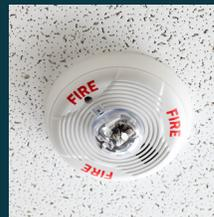
Installez des détecteurs de fumée et des dispositifs d'alerte qui répondent aux besoins des personnes sourdes ou malentendantes. Ces dispositifs comprennent des lumières stroboscopiques clignotantes pour les alertes visuelles, et un vibreur d'oreiller ou de matelas activé par le son d'un détecteur de fumée standard.
