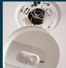
Lors du remplacement de détecteurs de fumée interconnectés, il est recommandé de remplacer toutes les unités du système en même temps. Si vous devez remplacer un seul détecteur défaillant, assurez-vous que le nouveau détecteur est compatible avec les unités existantes.
