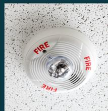
Instale detetores de fumo e dispositivos de alerta que correspondam às necessidades de pessoas surdas ou com deficiências auditivas. Tais dispositivos incluem luzes estroboscópicas intermitentes para alertas visuais, e uma almofada ou um agitador de cama ativado pelo som de um detetor de fumo padrão.
