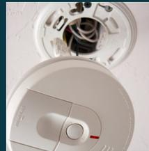
Quando substituir detetores de fumo interligados, recomendamos que substitua todas as unidades do sistema simultaneamente. Se tiver que substituir um único detetor avariado, certifique-se de que o novo detetor é compatível com as unidades existentes.
