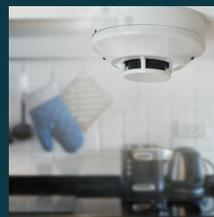
Se o seu detetor de fumo ativa constantemente quando está a cozinhar NÃO RETIRE A PILHA OU O DETETOR. Instale o detetor noutra local ou substitua-o por uma unidade fotoelétrica.
